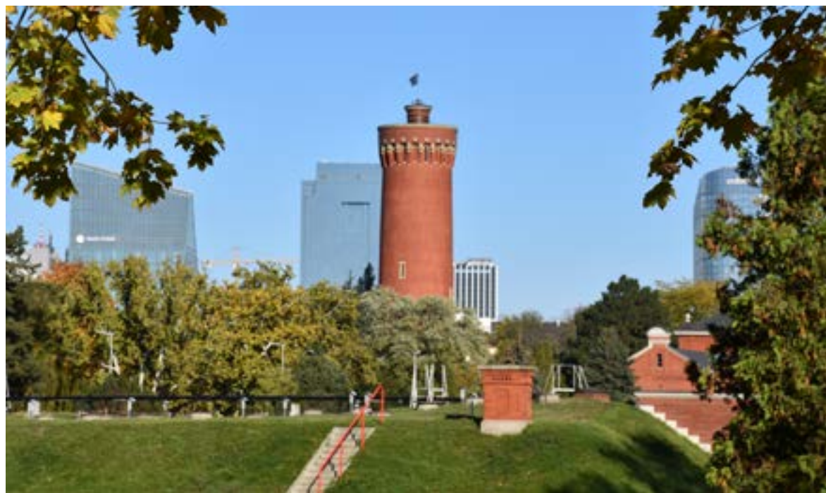
Zabytkowa Wieża Ciśnień na Stacji Filtrów, fot. archiwum MPWiK Historic Water Tower at the Filter Station, photo from the archive of MPWiK
