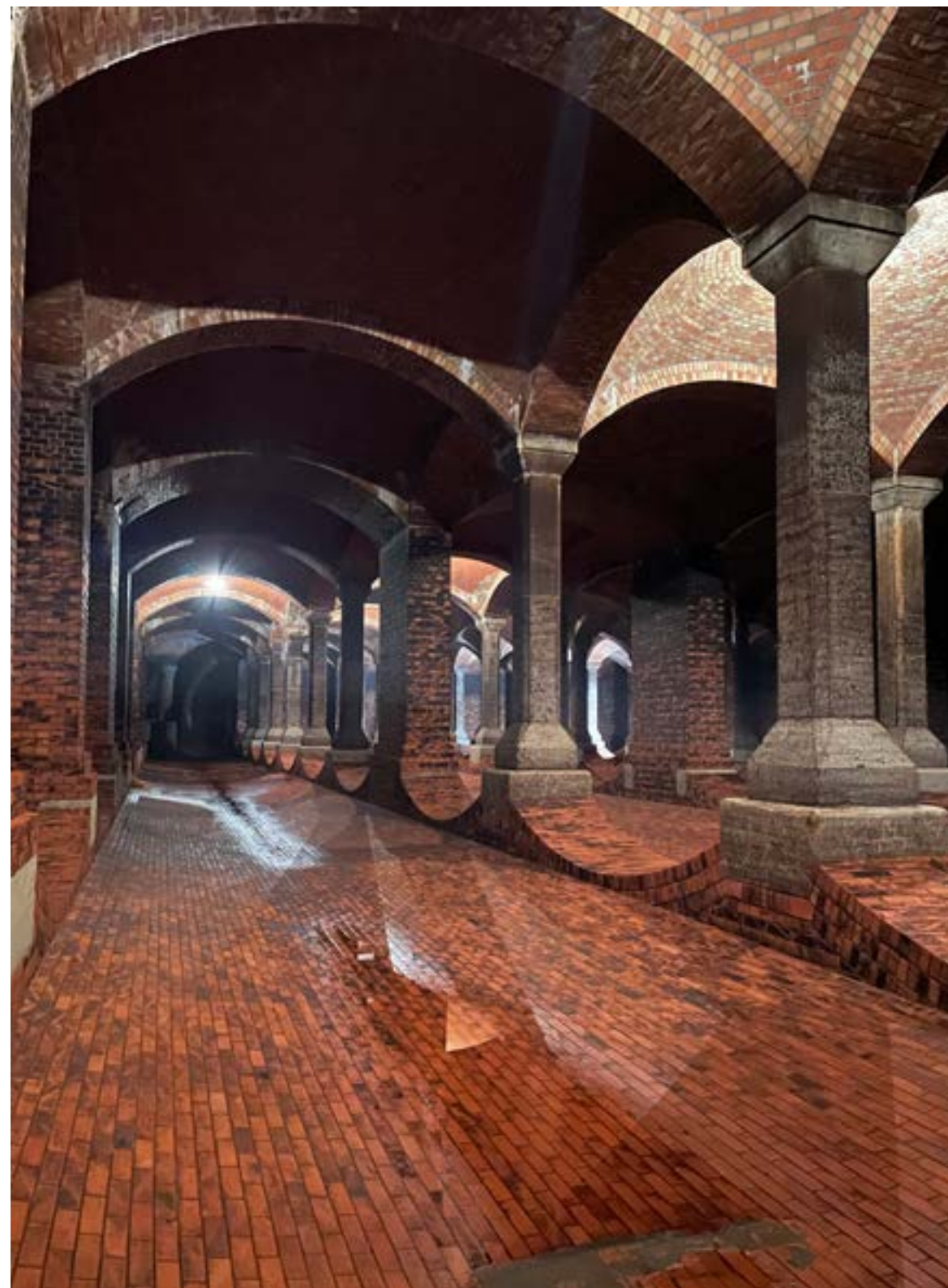
Zbiornik Wody Czystej, fot. archiwum MPWiK Clean Water Tank, photo from the archive of MPWiK
