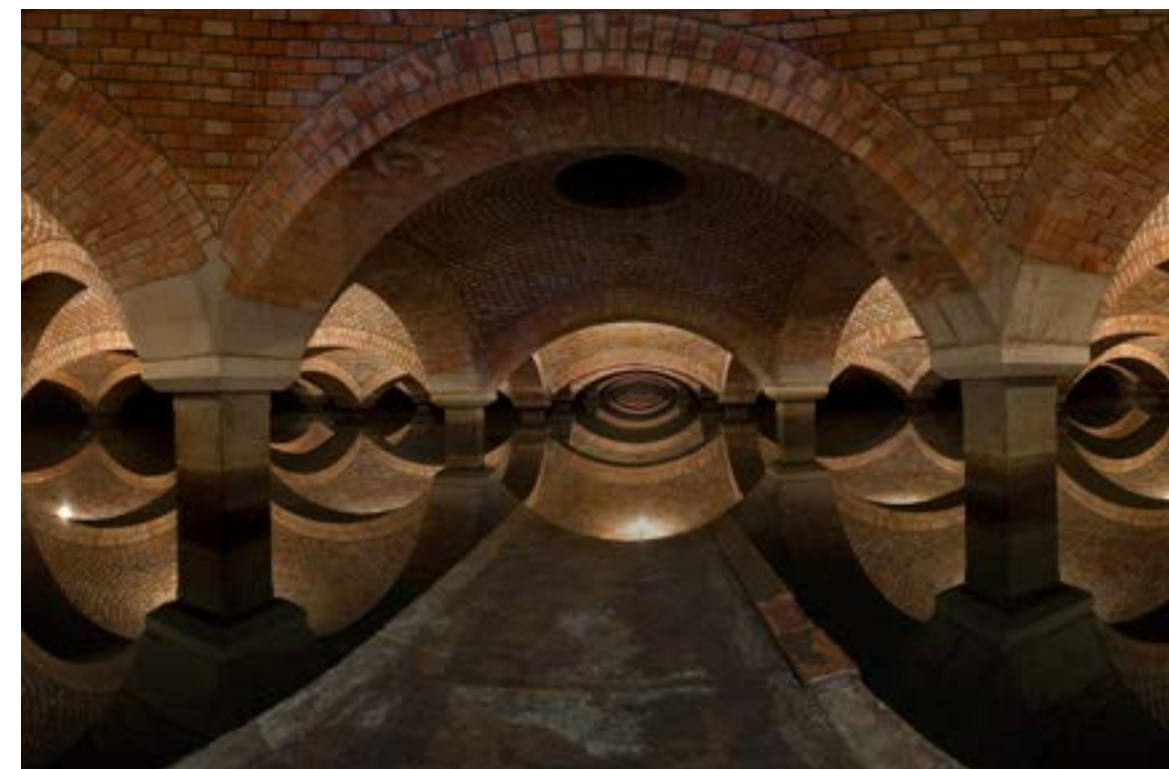
Zbiornik Wody Czystej, fot. archiwum MPWiK Clean Water Tank, photo from the archive of MPWiK
