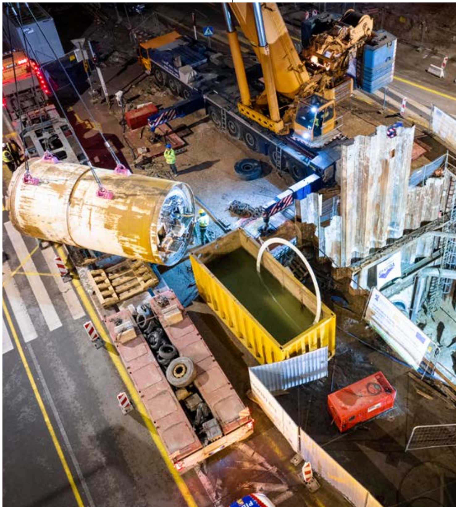
Budowa Kolektora Mokotowskiego Bis, fot. archiwum MPWiK Construction of the Mokotowski Bis Collector, photo from the archive of MPWiK
