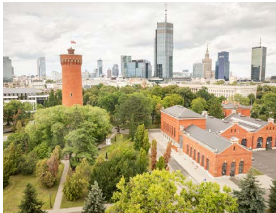
Wieża Ciśnień na Stacji Filtrów, fot. Jacek Turczyk The Water Tower at the Filter Station, photo by Jacek Turczyk
