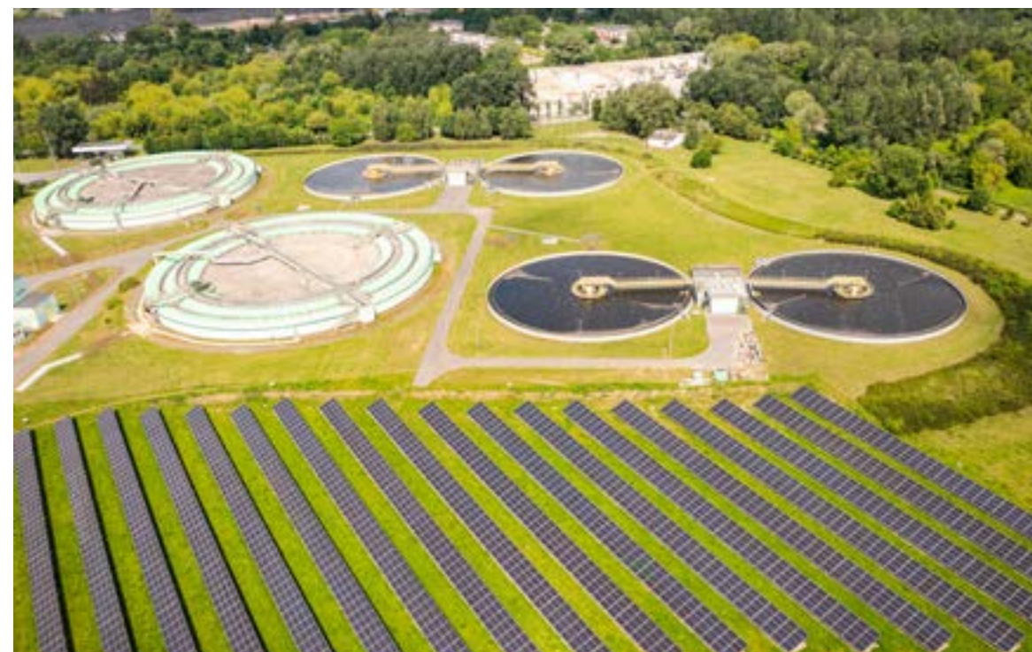
Panele PV w Zakładzie Południe fot. Jacek Turczyk Photovoltaic panels at the "Południe" Plant, photo by Jacek Turczyk
