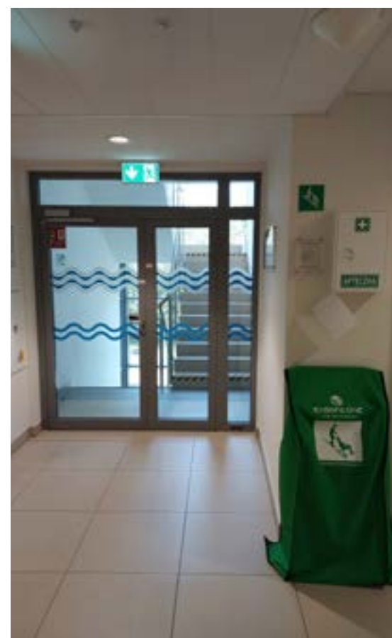
Kontrastowe oznaczenie drzwi (ul. Zaruskiego 4), fot. archiwum MPWiK Contrasting door marking (ul. Zaruskiego 4), photo from the archive of MPWiK
