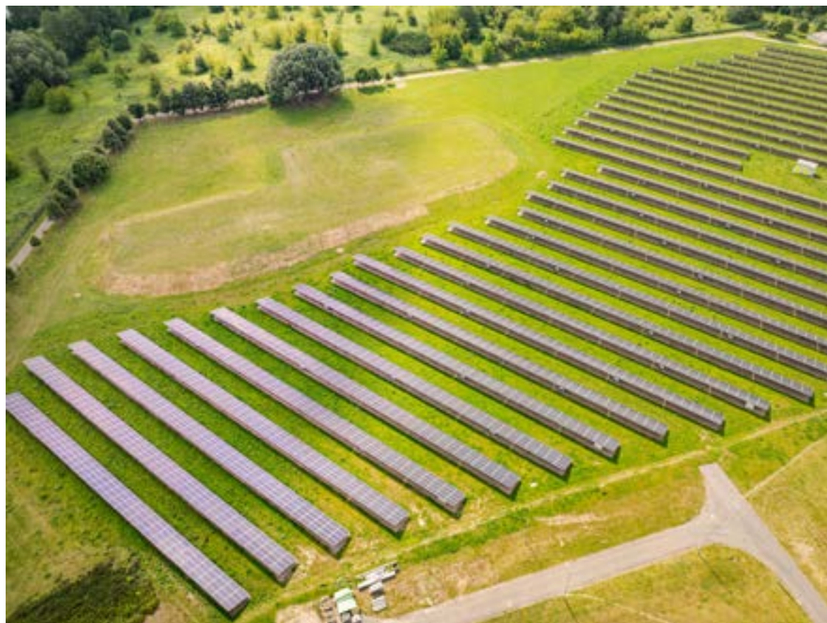
Panele fotowoltaiczne, fot. Jacek Turczyk Photovoltaic panels, photo by Jacek Turczyk
