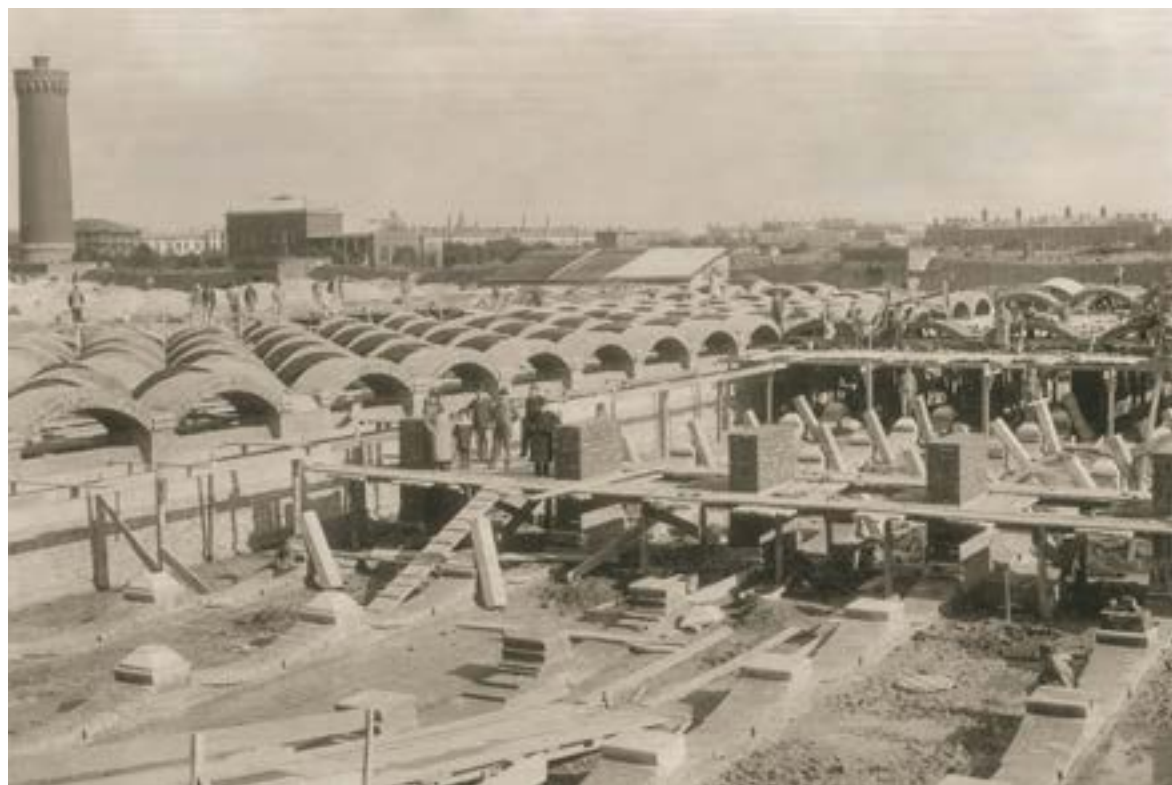
Podczas budowy Stacji Filtrów, fot. archiwum MPWiK During construction works of the Filter Station, photo from the archive of MPWiK
