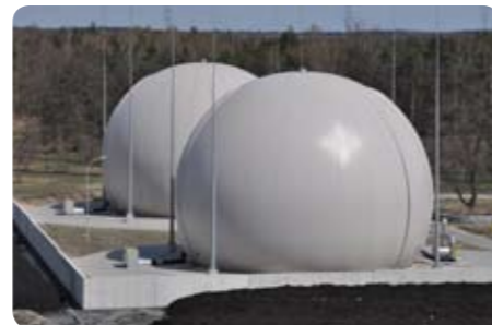
Zbiorniki biogazu, fot. MPWiK
