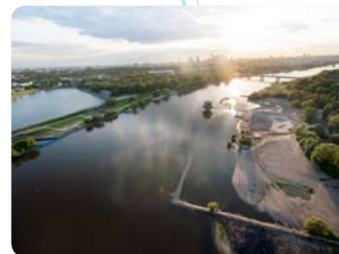
Panorama Wisły z widokiem na ujęcie wody „Gruba Kaśka”, fot. K.Kowalski/Aeromedia
