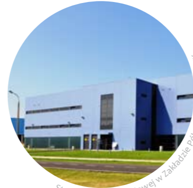
Stacja flotacji ciśnieniowej w Zakładzie Północnym, fot. MPWiK
