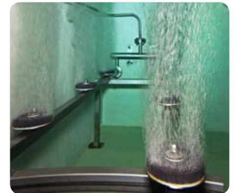
Wnętrze komory ozonowania, fot. K.Kobus / Travelphoto
