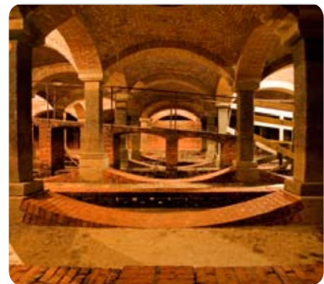
Wnętrze filtra powolnego, fot. K. Gajewski, M. Szal dla MPWiK
