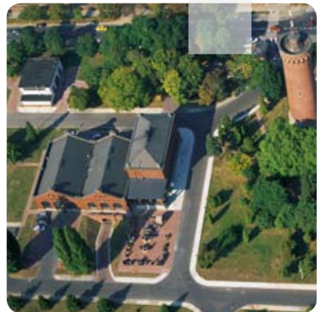
Widok na SUW „Filtry”, fot. M. Ostrowski
