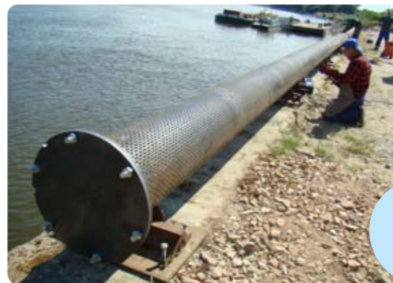
Dreny czekające na montaż, fot. M.Wojewódzka/MPWiK
