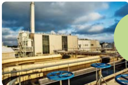
Stacja Termicznej Utylizacji Osadów Ściekowych, fot. S.Klorek
