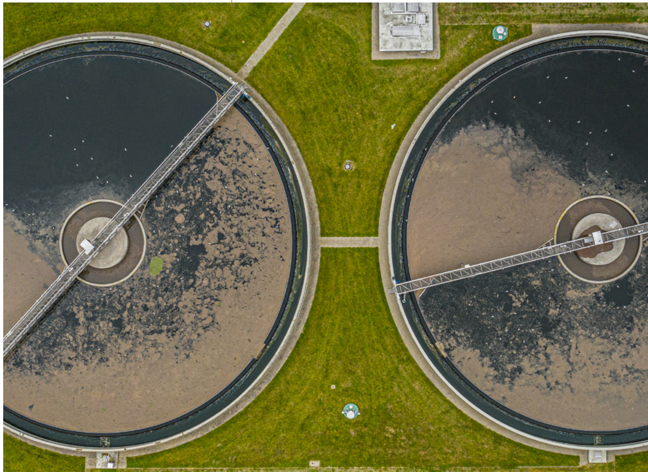
Widok na Oczyszczalnię Ścieków „Czajka”, fot. Simple Frame
