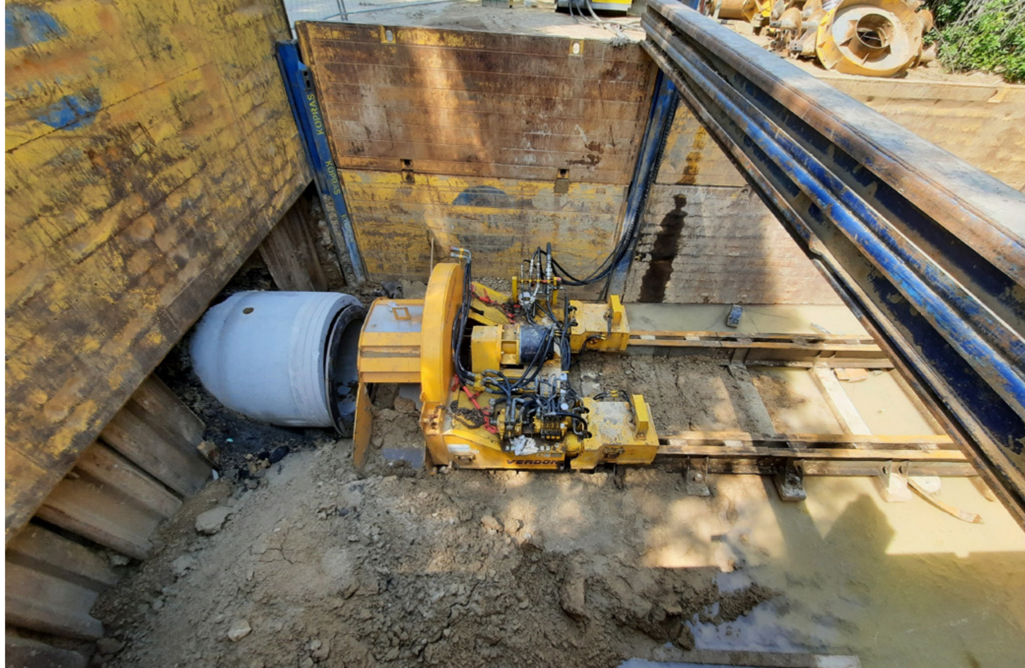
Budowa magistrali zasilania w wodę Pasma Pruszkowskiego, fot. archiwum MPWiK
