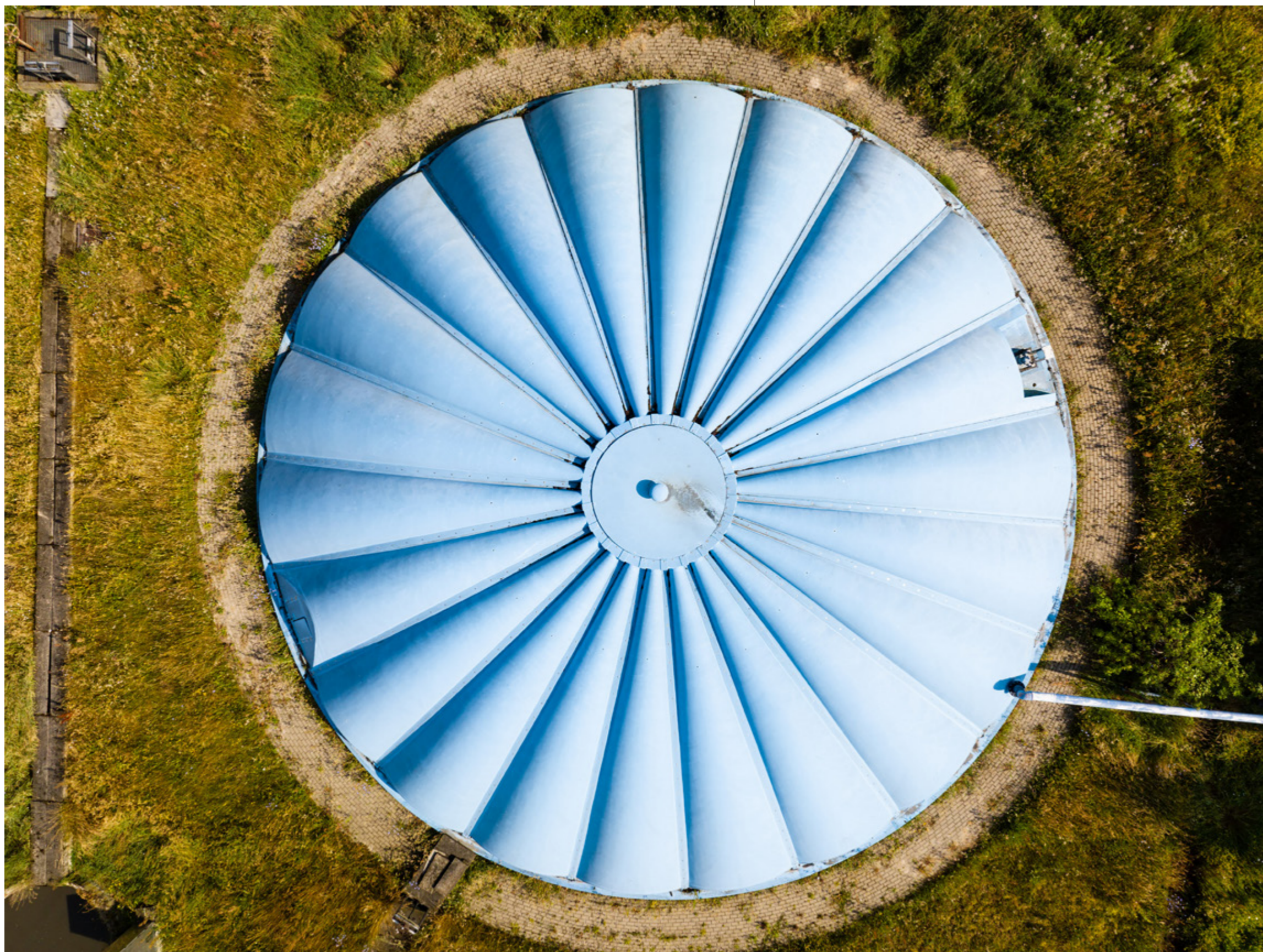
Osadnik wstępny w Oczyszczalni Ścieków „Dębe”, fot. Jacek Turczyk
