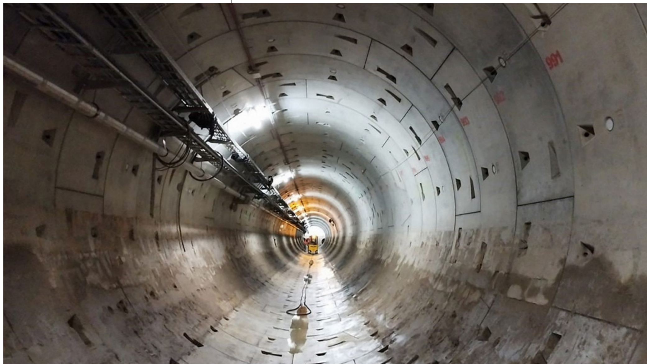
Wnętrze kolektora pomiędzy Zakładami „Świderska” i „Farysa”, fot. archiwum MPWiK
