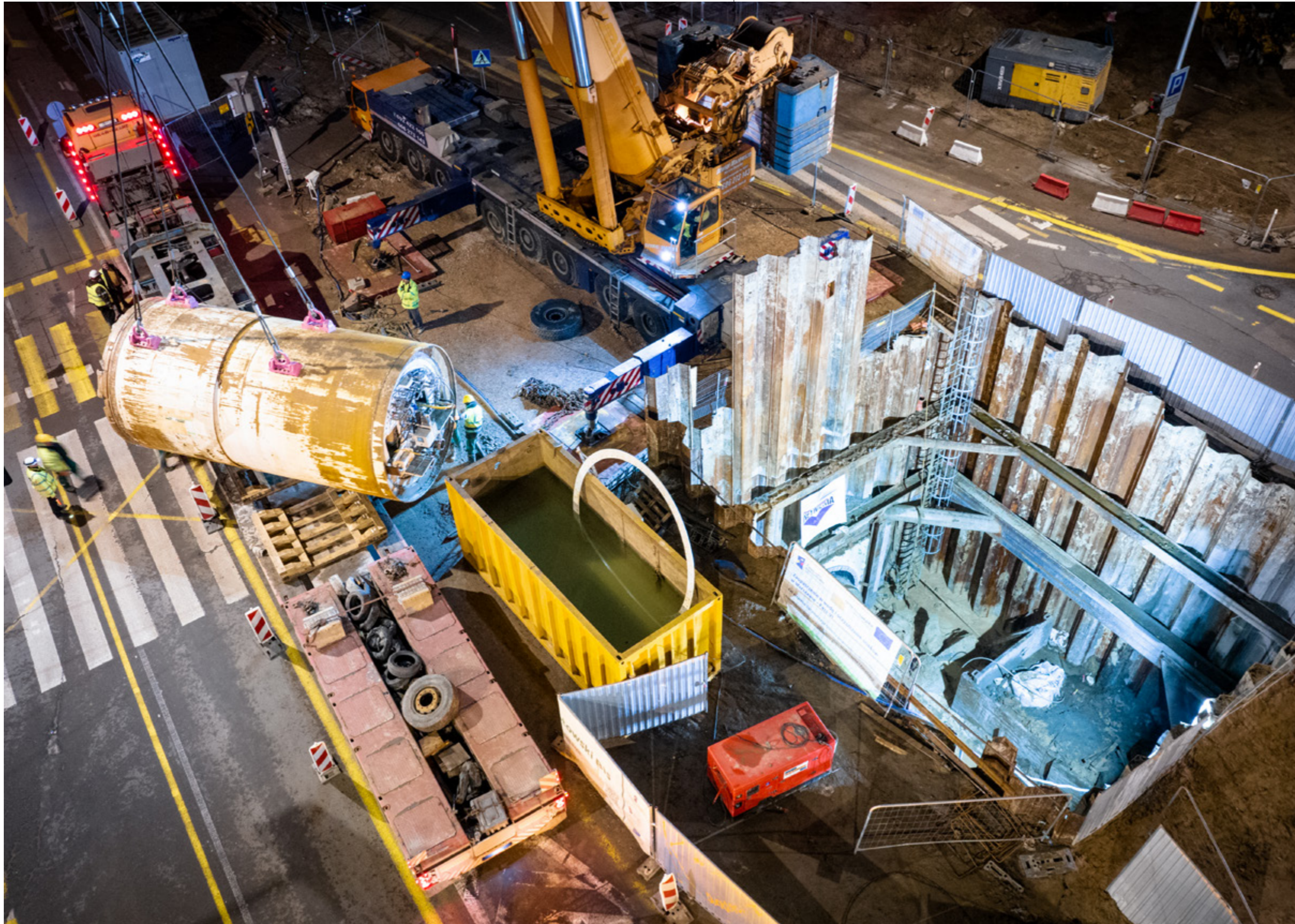
Podczas budowy Kolektora Mokotowskiego Bis, fot. archiwum MPWiK
