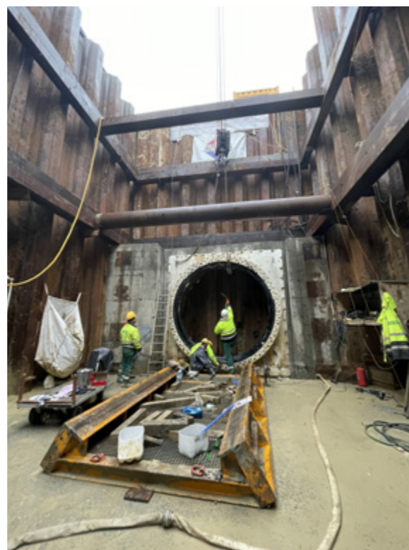
Budowa Kolektora Mokotowskiego Bis, fot. archiwum MPWiK
