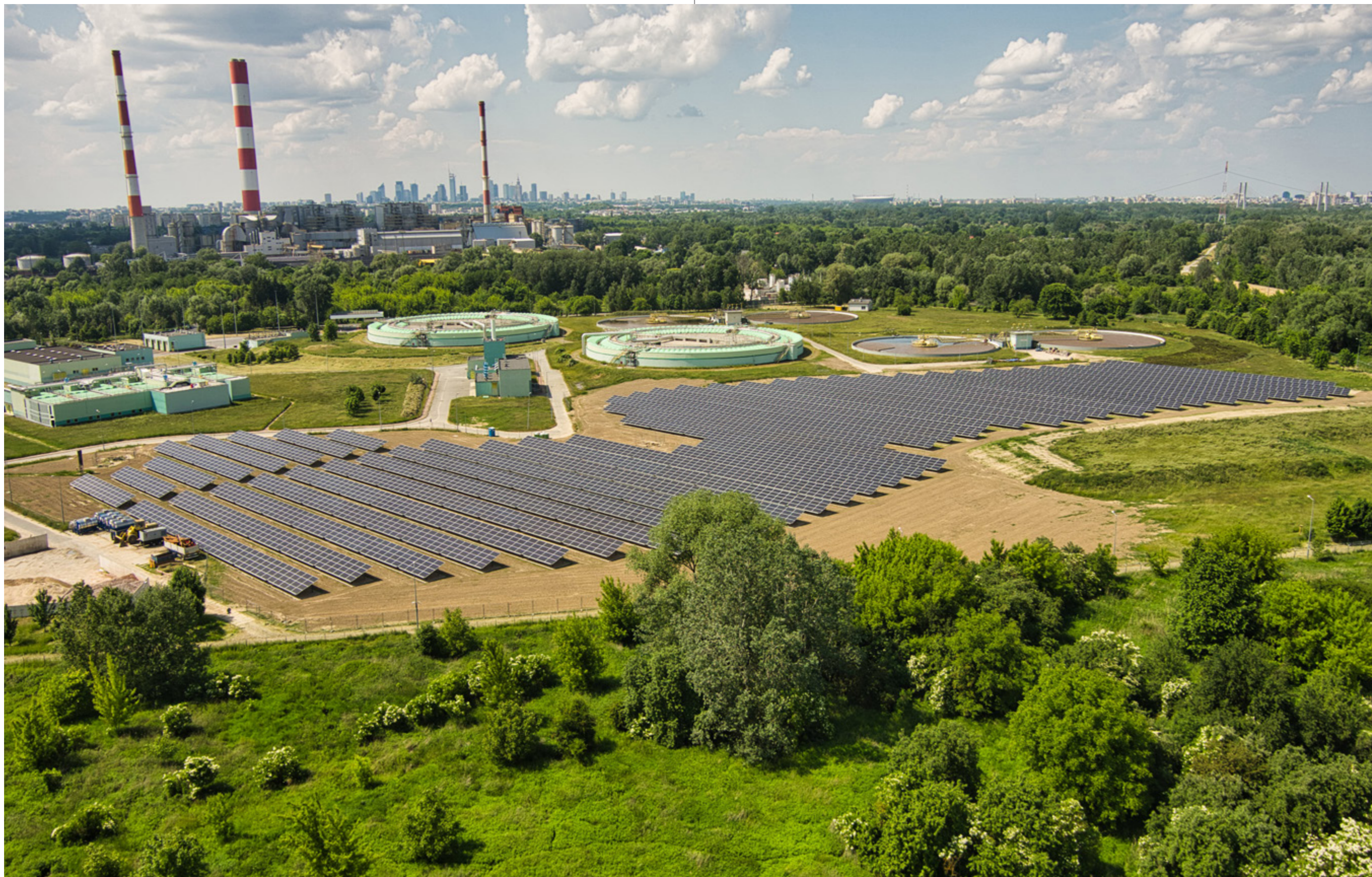
Farma fotowoltaiczna w Zakładzie Południe, fot. ML System SA
