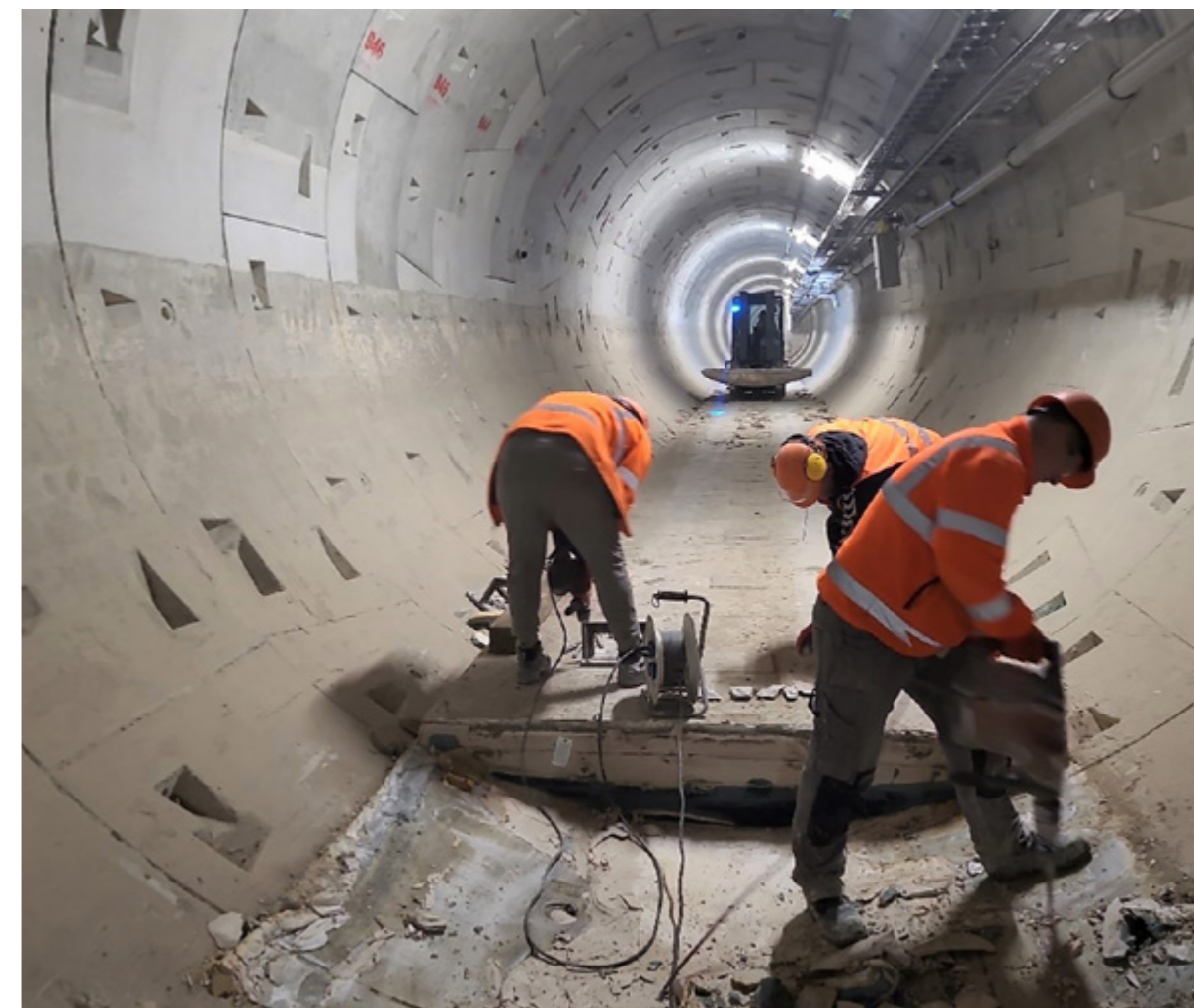
Budowa rurociągu na odcinku Farysa-Świderska, fot. archiwum MPWiK
