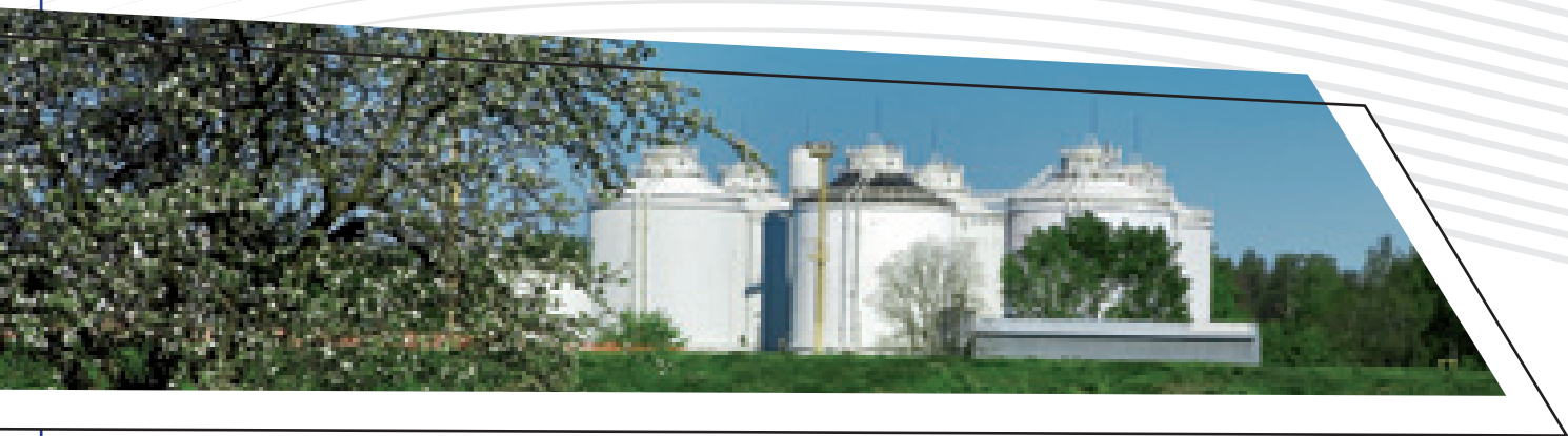
Oczyszczalnia Ścieków „Czajka”, fot. Krzysztof Kobus/Travelphoto.
