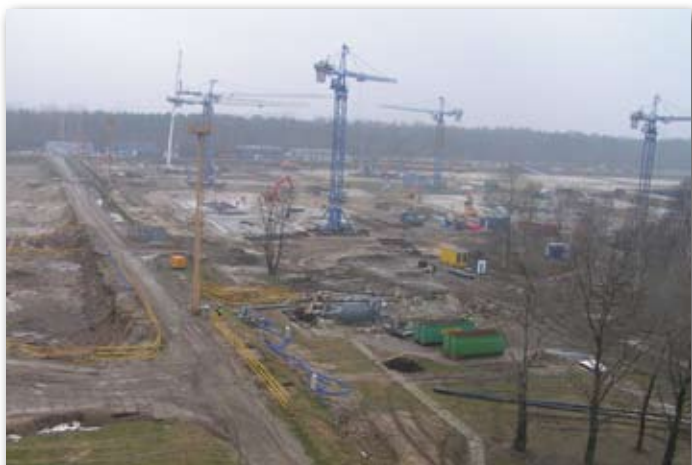
Modernizacja i rozbudowa Zakładu Oczyszczalni Ścieków „Czajka”, fot. archiwum MPWiK
