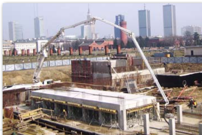
Modernizacja Zakładu Wodociągu Centralnego, fot. archiwum MPWiK
