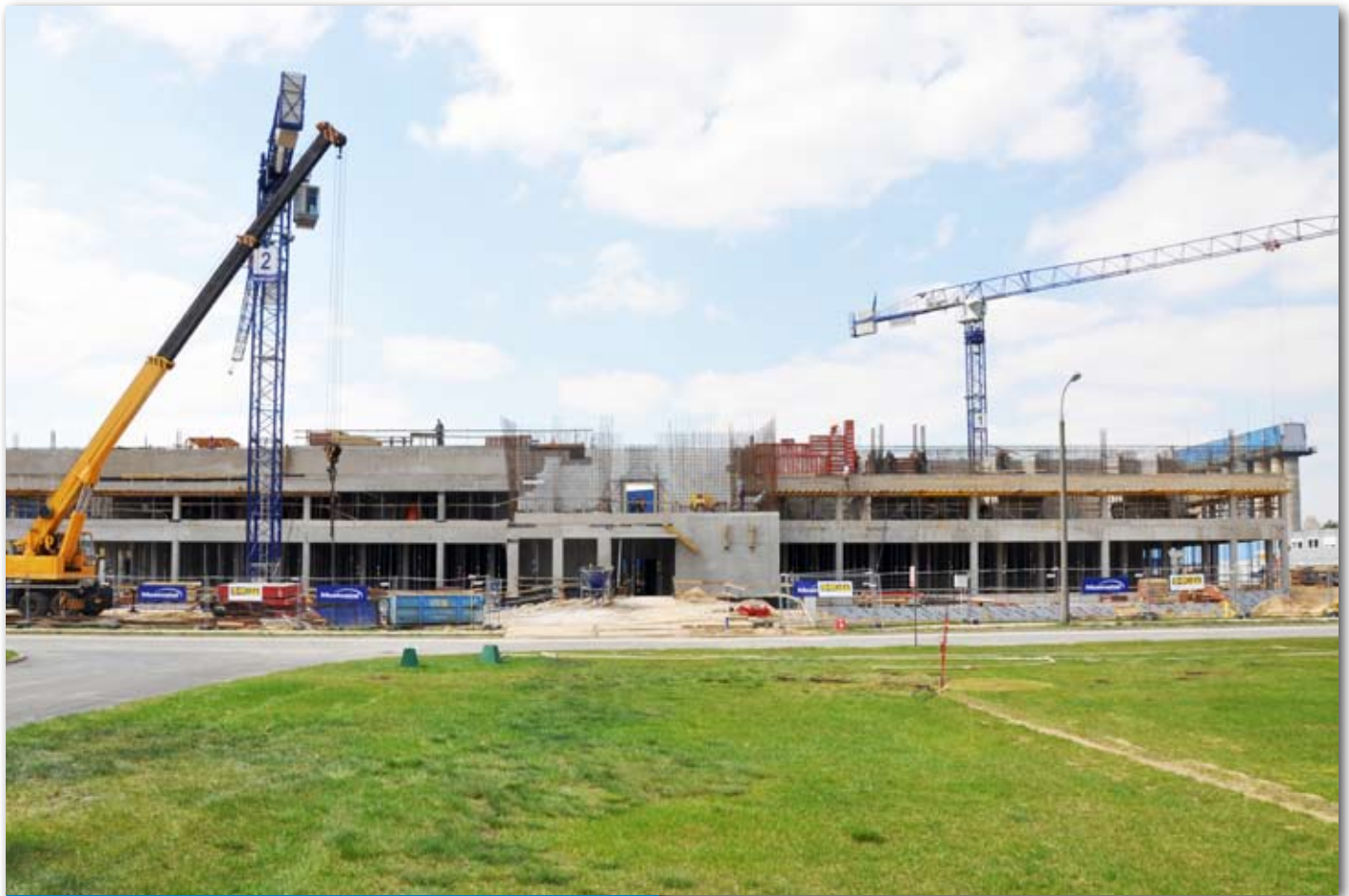
Modernizacja Zakładu Wodociągu Północnego, fot. archiwum MPWiK
