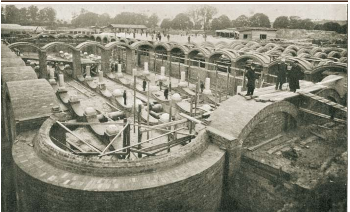
Budowa Stacji Filtrów 1886/ Construction of the Filter Station 1886 / fot. archiwum MPWiK
