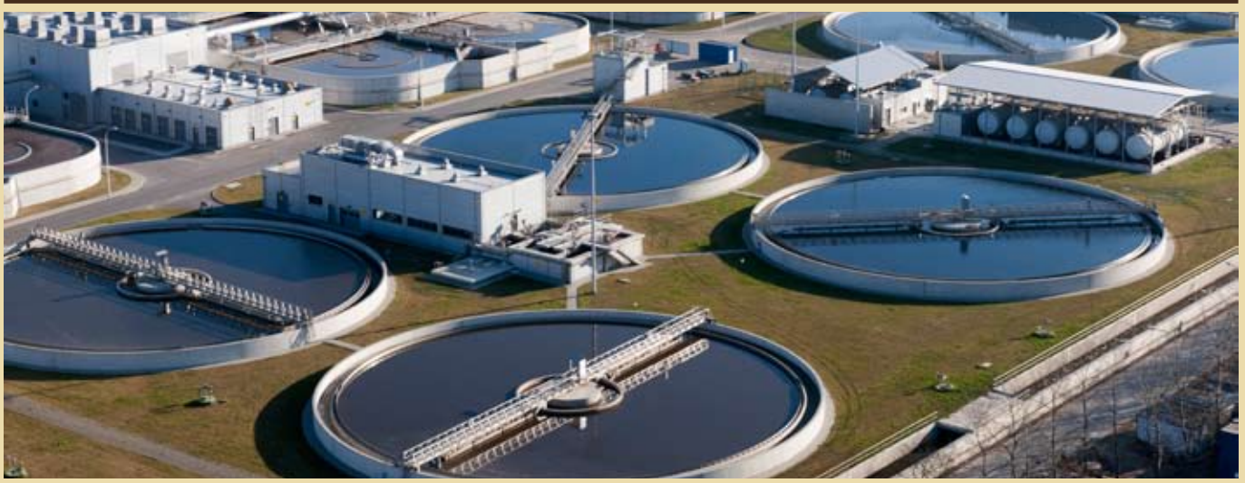
Osadniki w Oczyszczalni Ścieków Czajka / Sedimentation tanks at the „Czajka” sewage treatment plant / fot. Kacper Kowalski, Aeromedia
