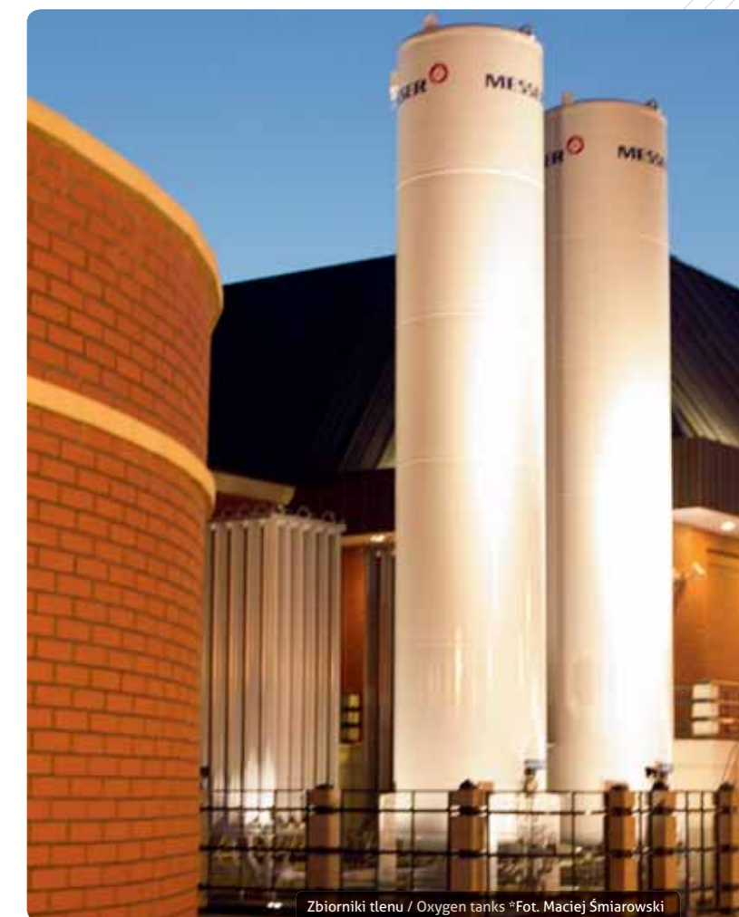
Zbiorniki tlenu / Oxygen tanks *Fot. Maciej Śmiarowski
