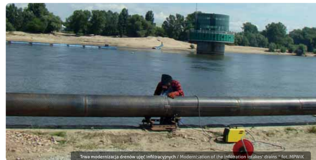
Trwa modernizacja drenów ujęć infiltracyjnych / Modernisation of the infiltration intakes' drains * fot. MPWiK
