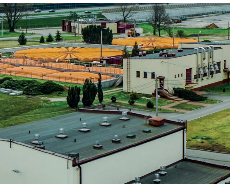
Stacja Termicznej Utylizacji Osadów Ściekowych na terenie Zakładu „Czajka” Fot. Krzysztof Kobus/Travelphoto.pl
