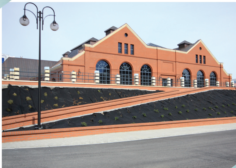
Stacja Ozonowania Pośredniego i Filtracji na Węglu Aktywnym. Fot. M. Cieszewski
