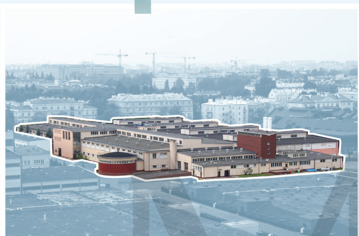
Budynek pulsatorów. Fot. archiwum MPWiK
