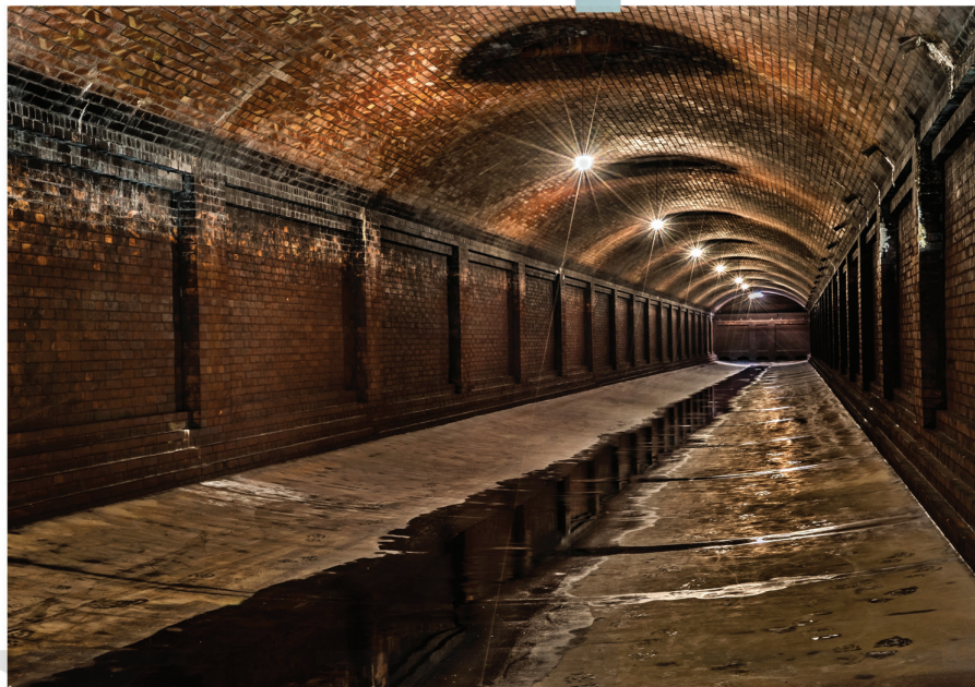
Wnętrze zbiornika wody surowej. Fot. W. Bliźniak
