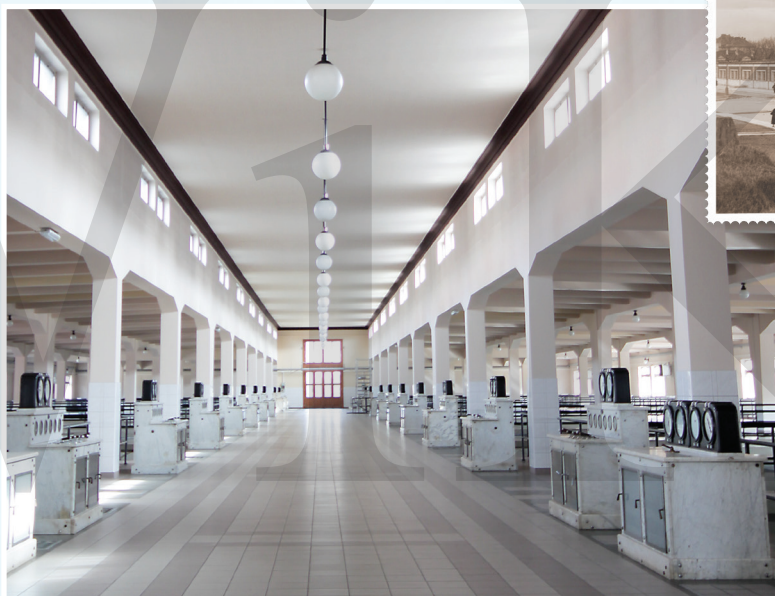
Hala Filtrów Zakładu Filtrów Pospiesznych. Fot. M. Cieszewski
