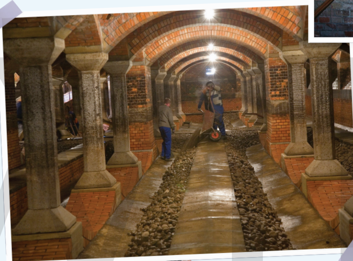
Wymiana złożeń w filtrze powolnym. Fot. K. Kobus, Travelphoto
