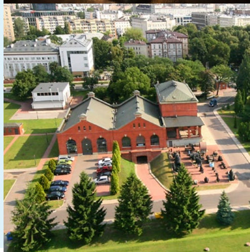
Zabytkowe budynki na terenie SUW „Filtry” Fot. Studio Awokado
