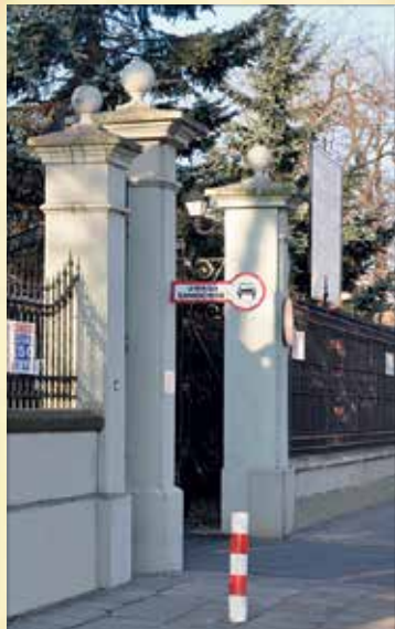
ogrodzenie i bramy
