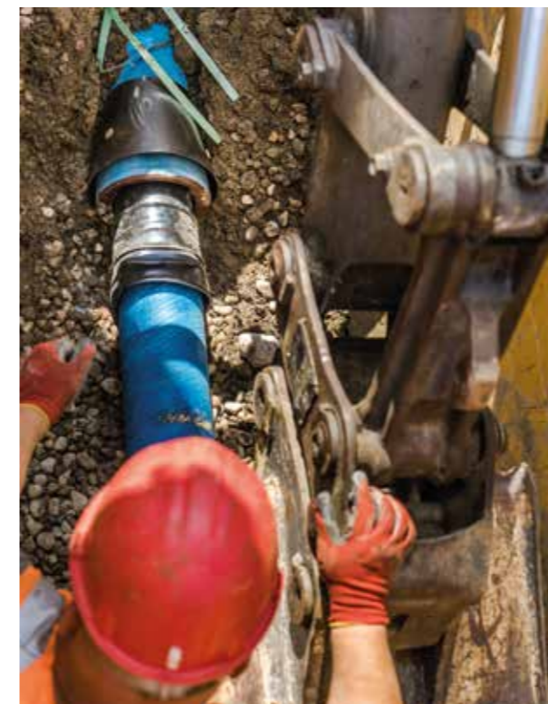
Prace przy modernizacji sieci wodociągowej / Modernisation of the water supply network Fot. Krzysztof Kobus/Travelphoto.pl
