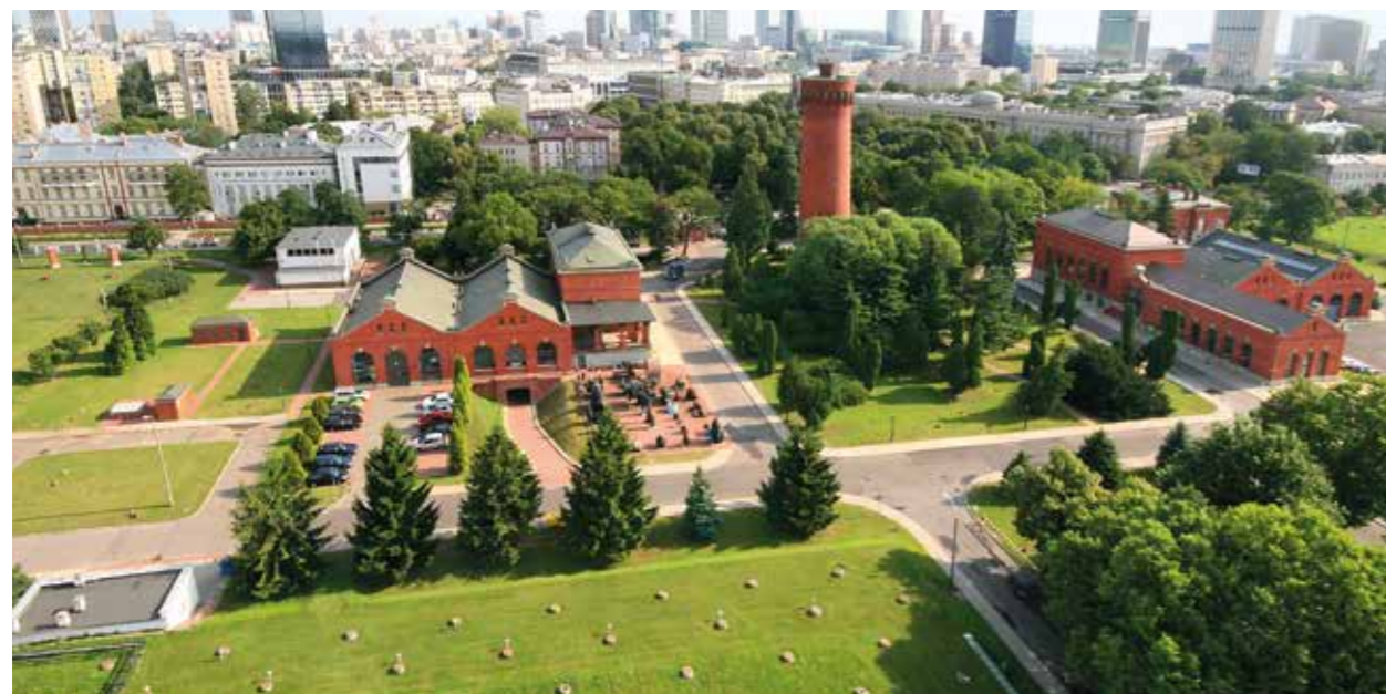
Wieża ciśnienia na terenie Stacji Uzdatniania Wody „Filtry” / The water tower at the „Filtry” water treatment station Fot. Krzysztof Kobus/Travelphoto
