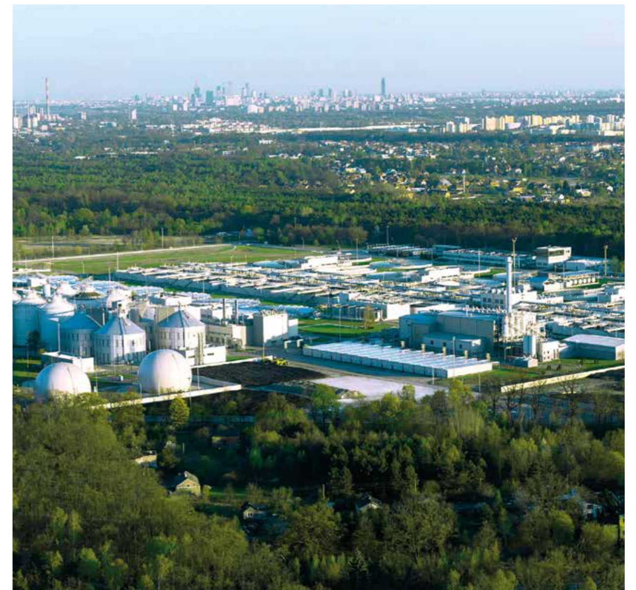
Zakład „Czajka” / "Czajka" Plant Fot. Aeromedia.pl
