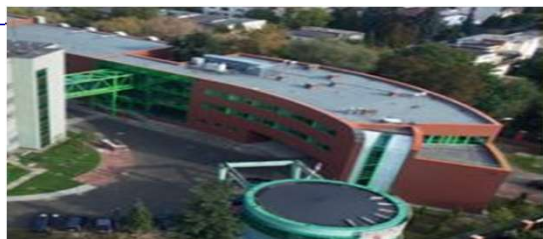
Stacja ozonowania pośredniego i filtracji na węglu aktywnym w SUW „Praga” lata 2013-2015 90,5 mln zł
