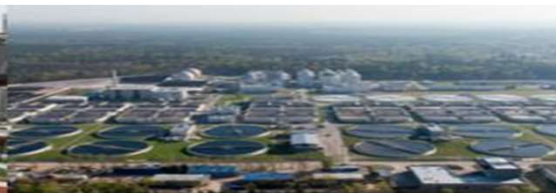
Modernizacja i rozbudowa oczyszczalni ścieków „Czajka” lata 2008-2012 2,1 mld zł
