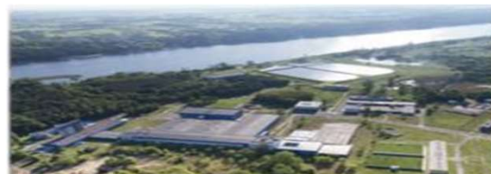
Stacja flotacji ciśnieniowej w Zakładzie Północnym lata 2006-2009 124 mln zł
