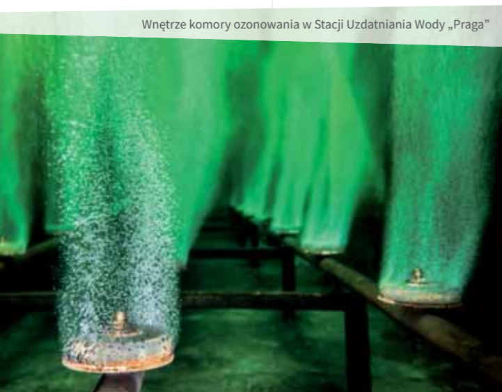
Stacja Uzdatniania Wody „Praga”. Szklana elewacja budynku ozonowania
