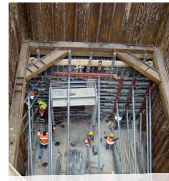
Prace w jednej z komór połączeniowych
