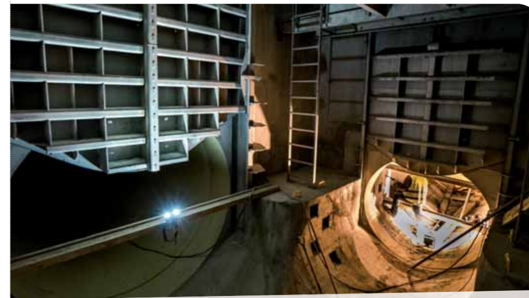
Ostatni etap budowy komory łączącej Kolektor Burakowski Bis ze starym kolektorem
